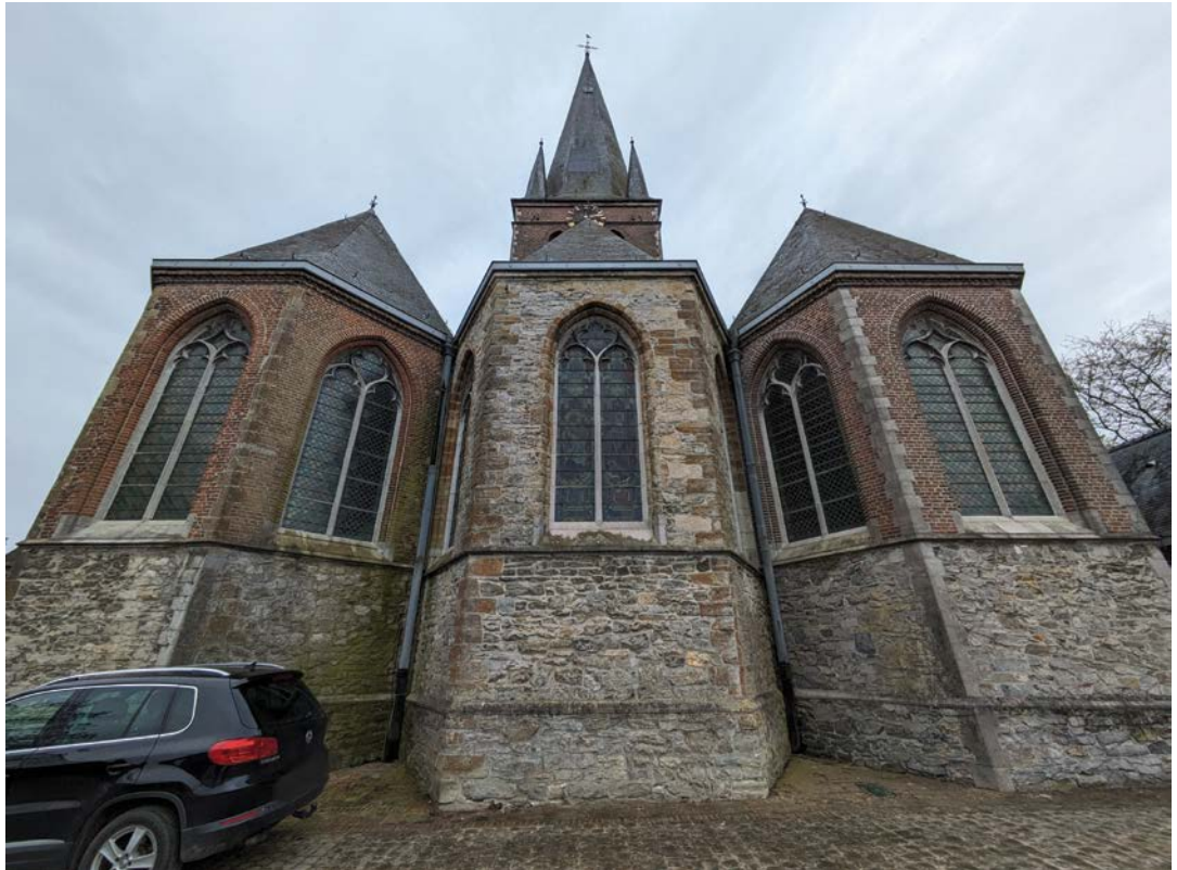
Afb. 13. In de achterzijde van het koor is in de middelste beuk een muur in natuursteen te zien. Is dit het enige bewaarde deel van een vorige kerkfase?
