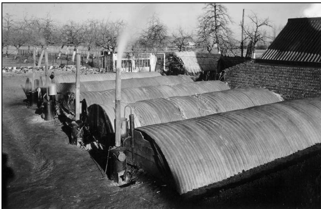
Fig. 65. Met golfplaten bedekte witloofbedden worden door een ondergronds verwarmingssysteem via kacheltjes verwarmd (fotograaf onbekend, 1945 - 1970, © collectie Centrum Agrarische Geschiedenis (CAG)).
