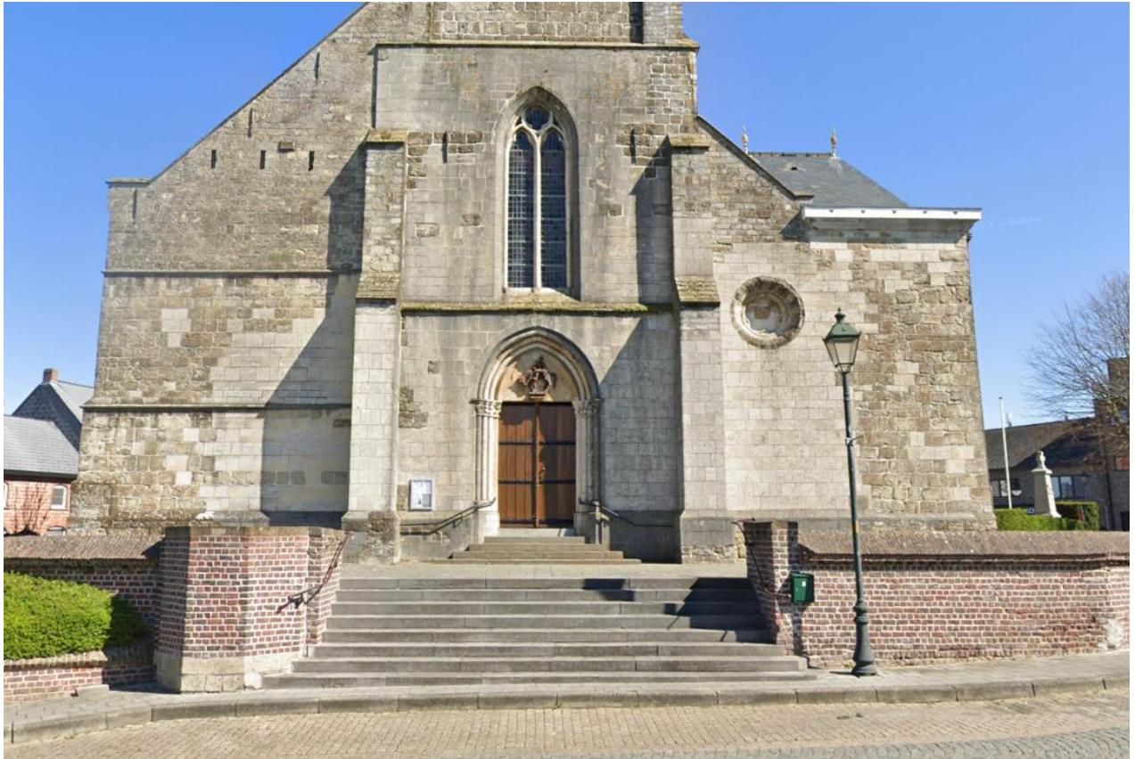
Foto 26: Huidig zicht op de westgevel van de kerk. De meest opvallende verschillen met de foto en prentkaarten vanaf 1942 zijn de toevoeging van de struikpartij en extra buitenmuur (links in beeld) en de gewijzigde gevel (rechts in beeld) door een verlaging van het dak aan de zuidkant van de kerk (Bron: Google Streetview). Aan de afwerking van de plint op bijvoorbeeld de steunbeer rechts vooraan is te zien dat het kerkhof oorspronkelijk (voor 1942) hoger lag.
