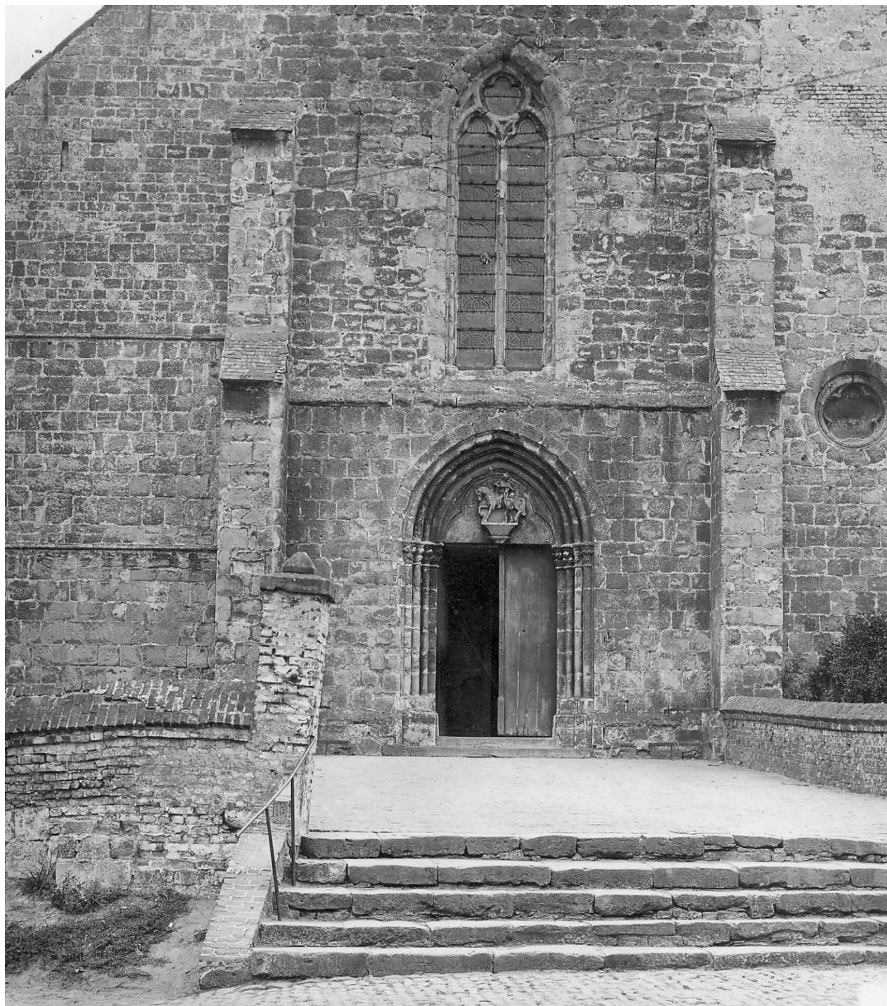
Foto 21: Foto uit 1932 van de westgevel van de kerk. Op de voorgrond links en rechts zijn delen van de oudere kerkhofmuur te zien. Een trap met vijf treden overbrugt het hoogteverschil tussen het straatniveau en het kerkhof (Bron: KIK-IRPA).
