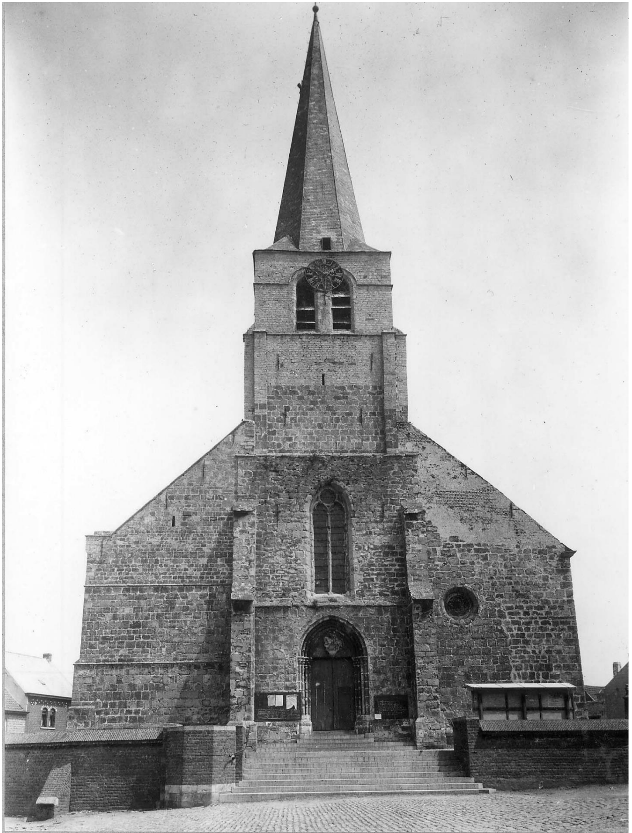
Foto 23: Foto uit 1942 met zicht op de westzijde van het kerkareaal. De kerkhofmuur en trappenpartij zijn pas verbouwd en zichtbaar in hun huidige vorm (zie Foto 26). Van de kerkingang daalt men nu vijf treden tot op het kerkhofniveau, vervolgens nog eens acht treden tot het straatniveau. Hieruit valt af te leiden dat niet alleen het kerkhof maar ook de straat verlaagd zijn (Bron: KIK-IRPA).
