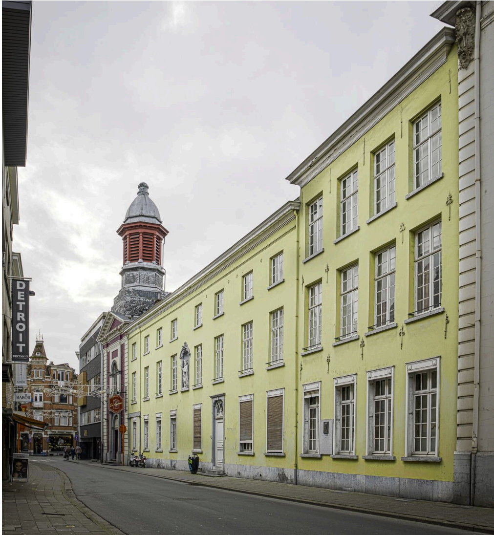
Figuur 16: het voormalige zwarte zustersklooster met rechts vooraan het huis de Kegel, ©Aalst.tv
