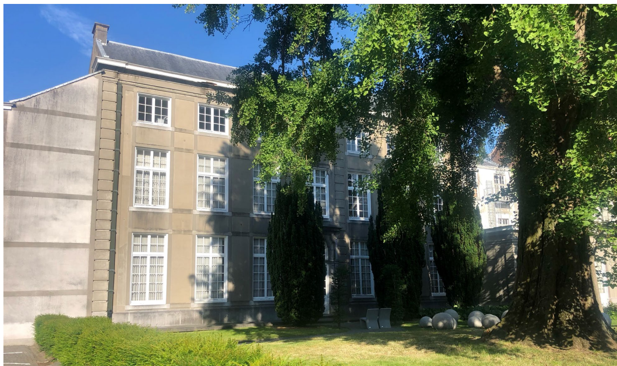
Foto 6: Zicht op de achterzijde van het Hotel Van Langenhove
