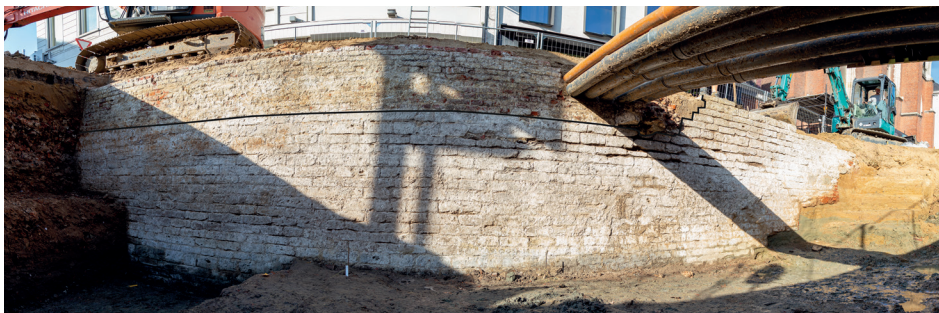
Zijaanzicht van de brug. De zwarte lijn geeft de 17de-eeuwse verbouwing aan. De in de 17de eeuw geplaatste aanbouw is op deze foto reeds verwijderd. (foto Dirk Wollaert)
