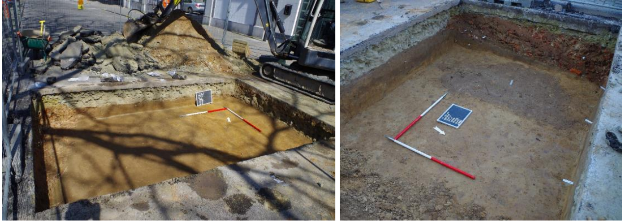
Afbeelding 25: links: zone IV na afgraven. Rechts: zone IV na het verdiepen naar een 2de grondvlak.
