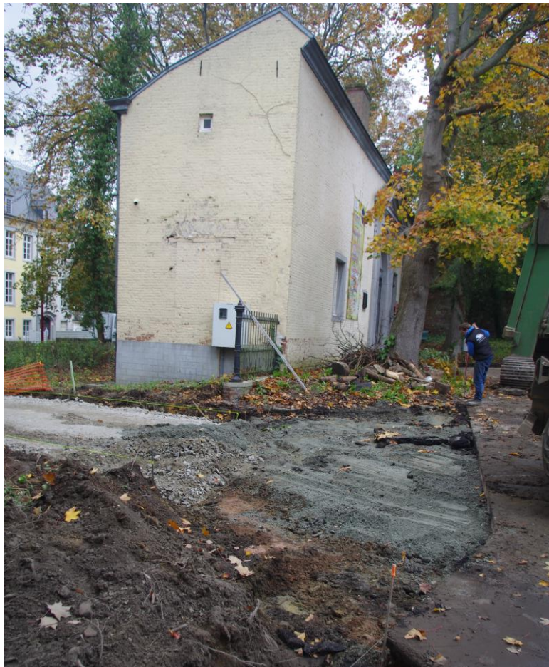
Foto 68 Aanleg van de dienstweg met de aansluiting naar de bestaande parking, zicht vanuit het zuidwesten. Op de achtergrond staat het poortgebouw
