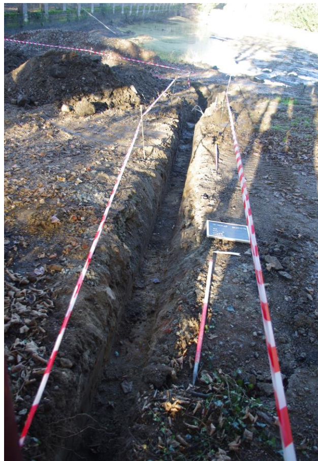
Foto 99 Uitgraving voor de nutsleidingen net ten zuiden van de vijver, zicht vanuit het zuiden. Op de achtergrond is de vijver te zien
