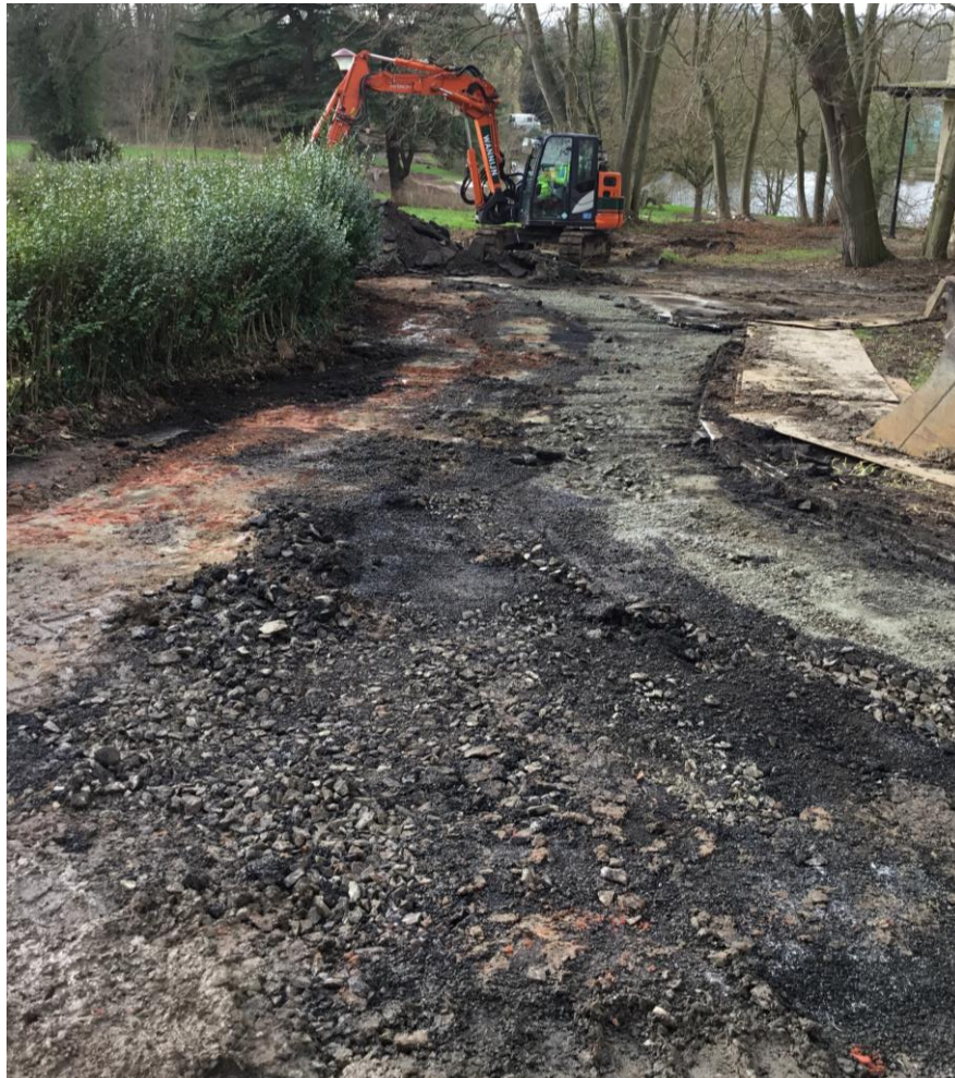
Foto 74 Opbraak van de wandelpaden ten noordoosten van de speelzone, gezien vanuit het noordoosten
