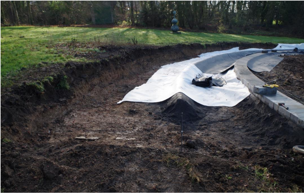
Foto 85 Uitgraving van de speelgoot, gezien vanaf het noorden
