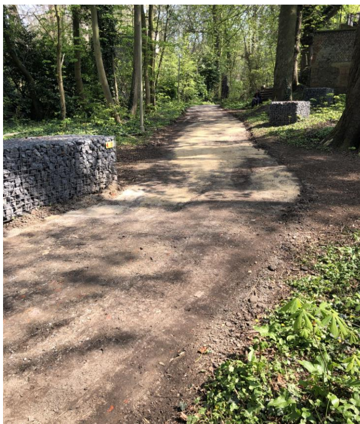
Foto 103 Heraanleg van een van de wandelpaden in de parkzone, zicht vanuit het westen
