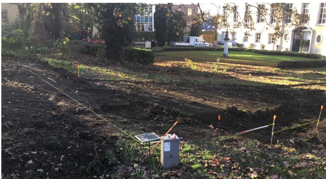
Foto 27 Afgraving in functie van de cortenstaal ter hoogte van het voormalige noordelijke transept van de abdijkerk, zicht vanuit het oosten. Links op de achtergrond is het poortgebouw aanwezig, rechts op de achtergrond het Abtenhuis
