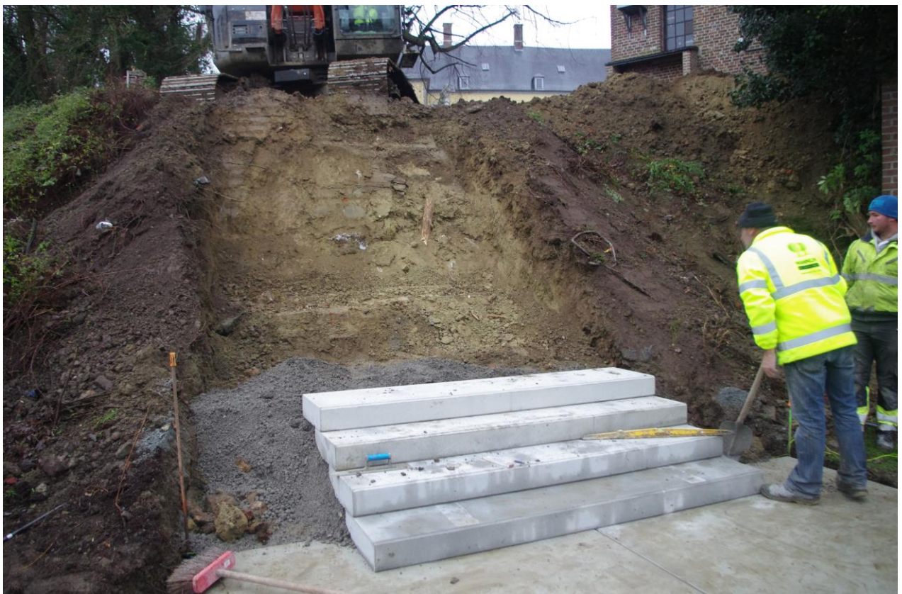
Foto 108 Onderste gedeelte van de uitgraving en aanleg van de trap, de uitgraving gebeurde in een recent opgevoerde berm, zicht vanuit het noordwesten
