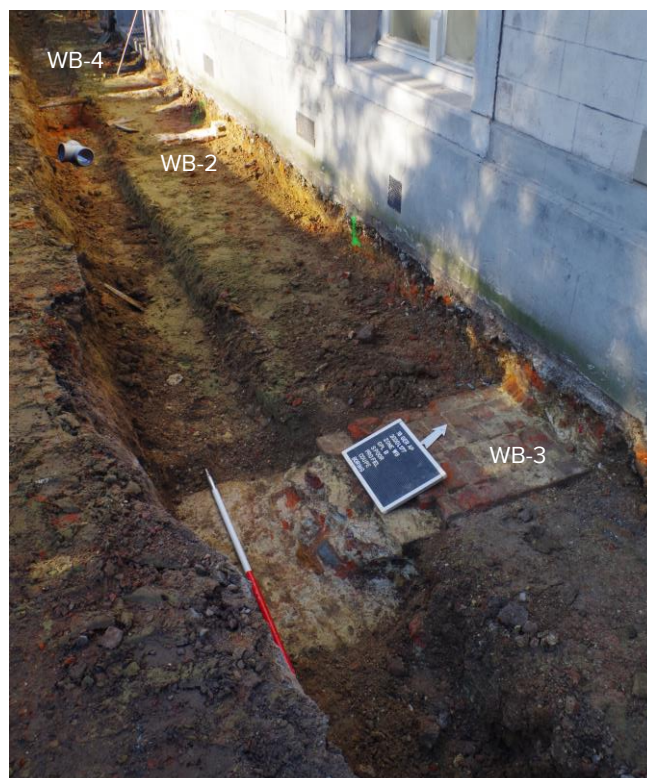
Foto 5 Opbraak van de bestaande toestand ter hoogte van de zuidoostelijke gevel van het Abtenhuis (grondplan A, Fig. 11) en aanleg van de nutsleidingen (grondplan B, Fig. 12), gezien vanuit het oosten
