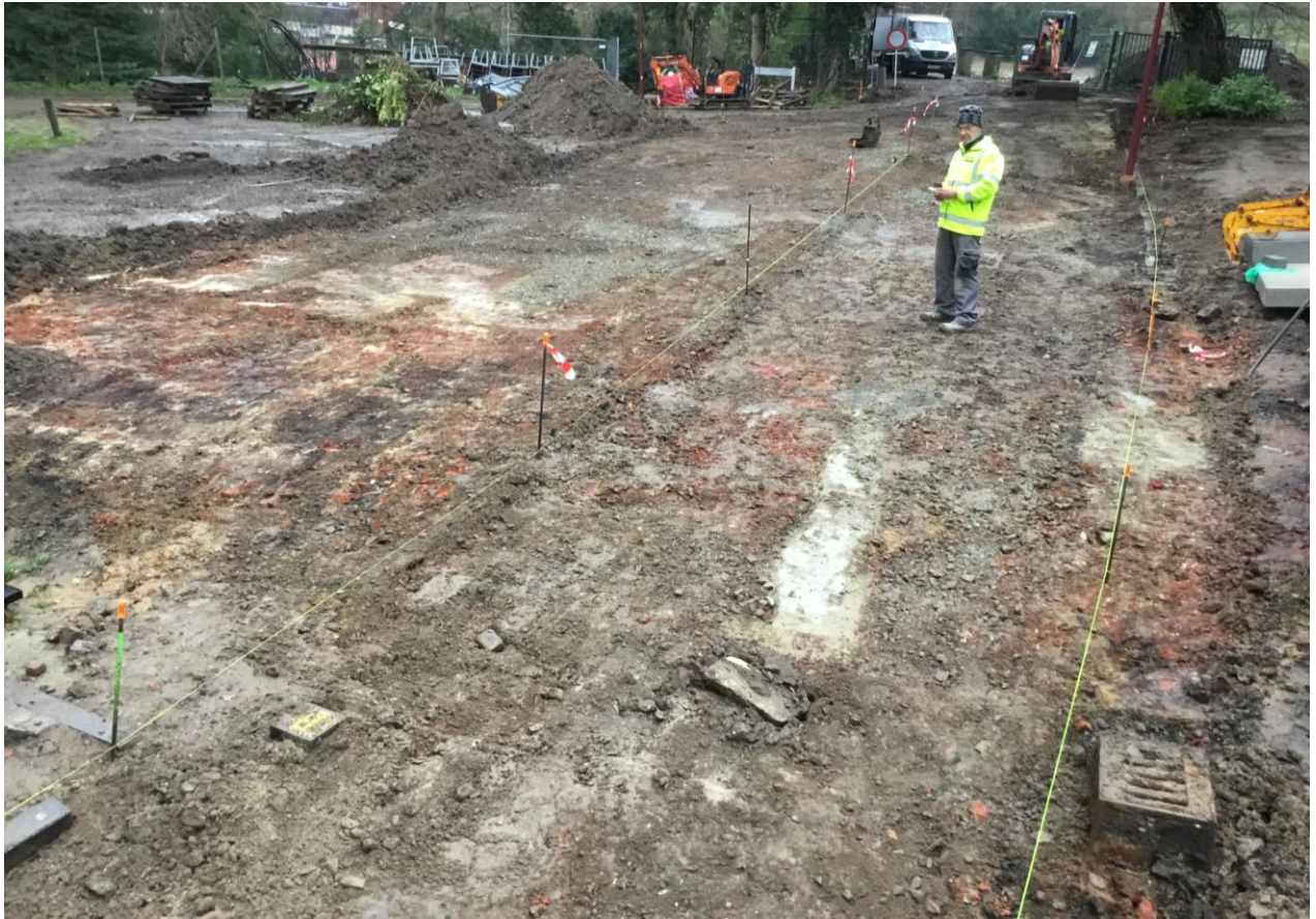
Foto 16 Aanleg van het grindgazon en het wandelpad ten oosten van het Abtenhuis, zicht vanuit het zuidwesten
