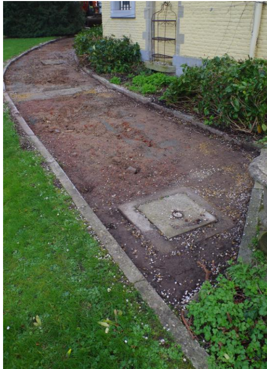
Foto 18 Opbraak van de bestaande toestand (wandelpad) ten noorden van het Abtenhuis, gezien vanaf het noordwesten.
