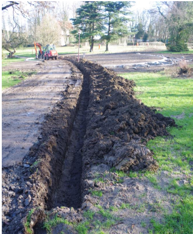
Foto 87 Sleuf voor de nutsleidingen richting het Chinees paviljoen, gezien vanuit het zuidwesten
