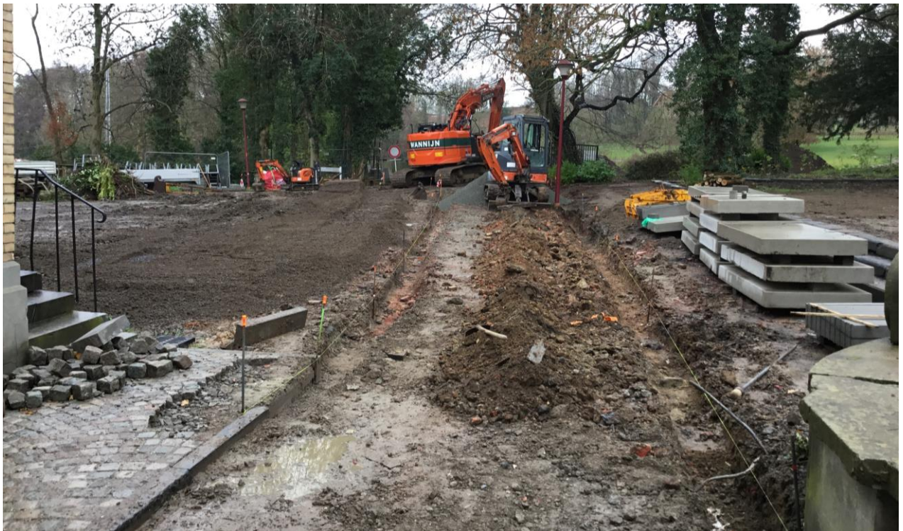
Foto 17 Aanleg van het grindgazon en het wandelpad ten oosten van het Abtenhuis met plaatselijk diepere uitgravingen voor de boordstenen, zicht vanuit het zuidwesten
