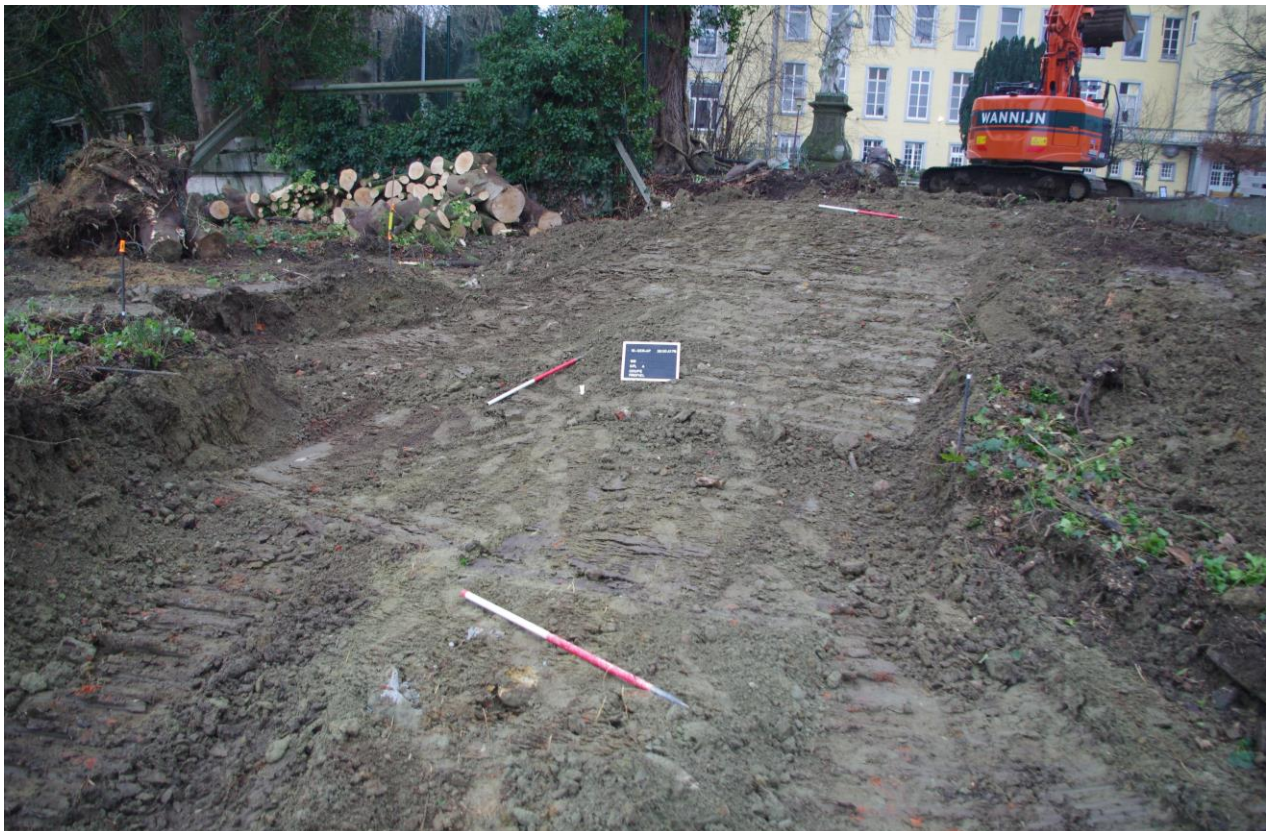
Foto 106 Bovenste gedeelte van de uitgraving van de trap, zicht vanuit het noordwesten. Op de achtergrond is het Abtenhuis te zien
