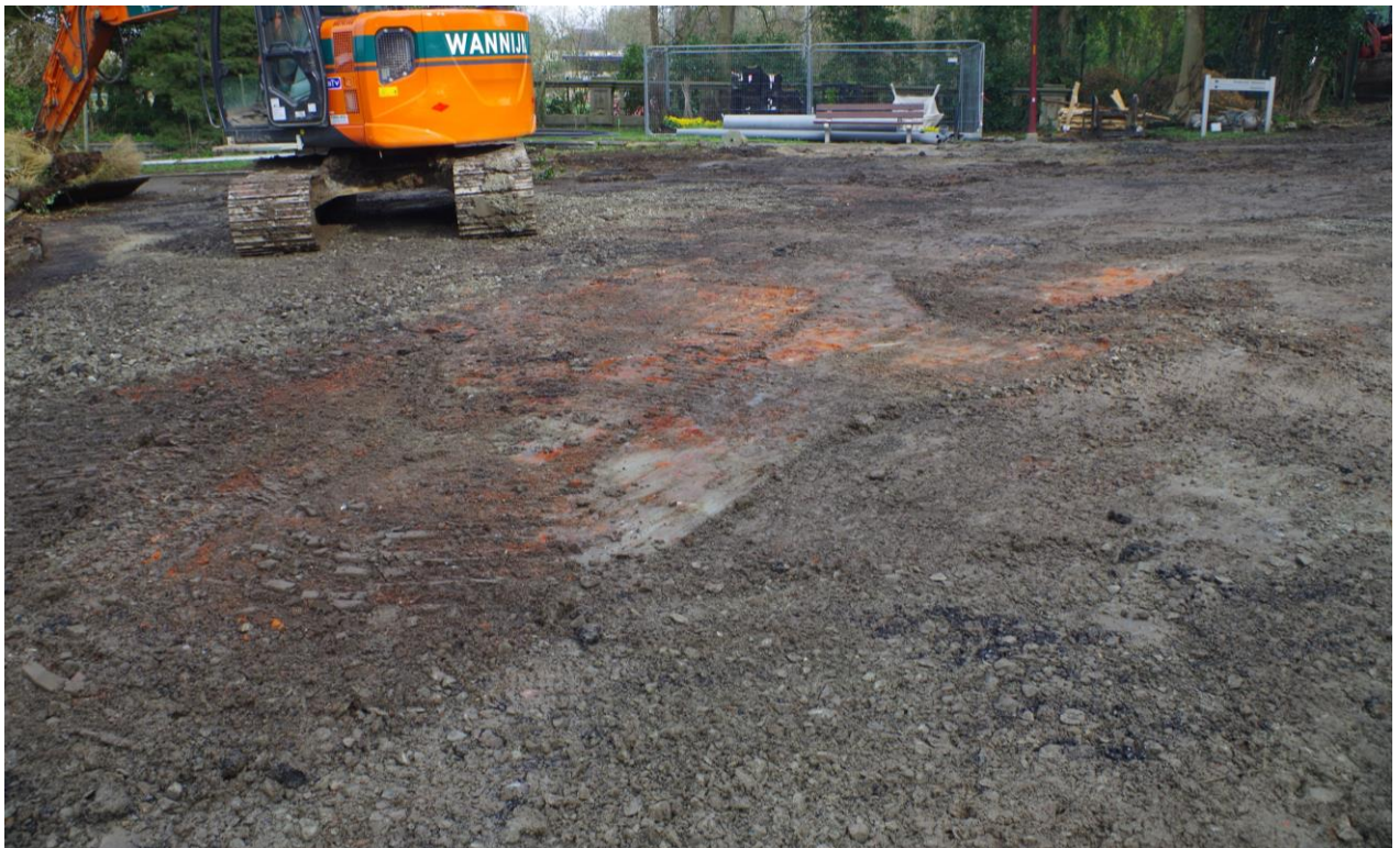
Foto 15 Opbraak van de bestaande toestand net ten noordoosten van het Abtenhuis, gezien vanuit het zuiden
