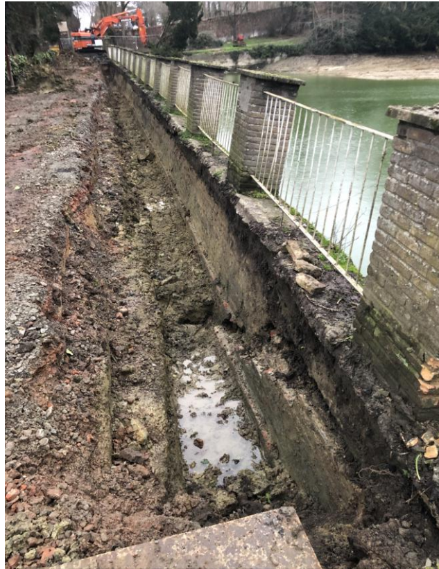
Foto 95 Uitgraving in functie van de verzakte vijvermuur, zicht vanuit het zuidwesten. Ook de aanpalende rijweg, links op de fot werd vernieuwd
