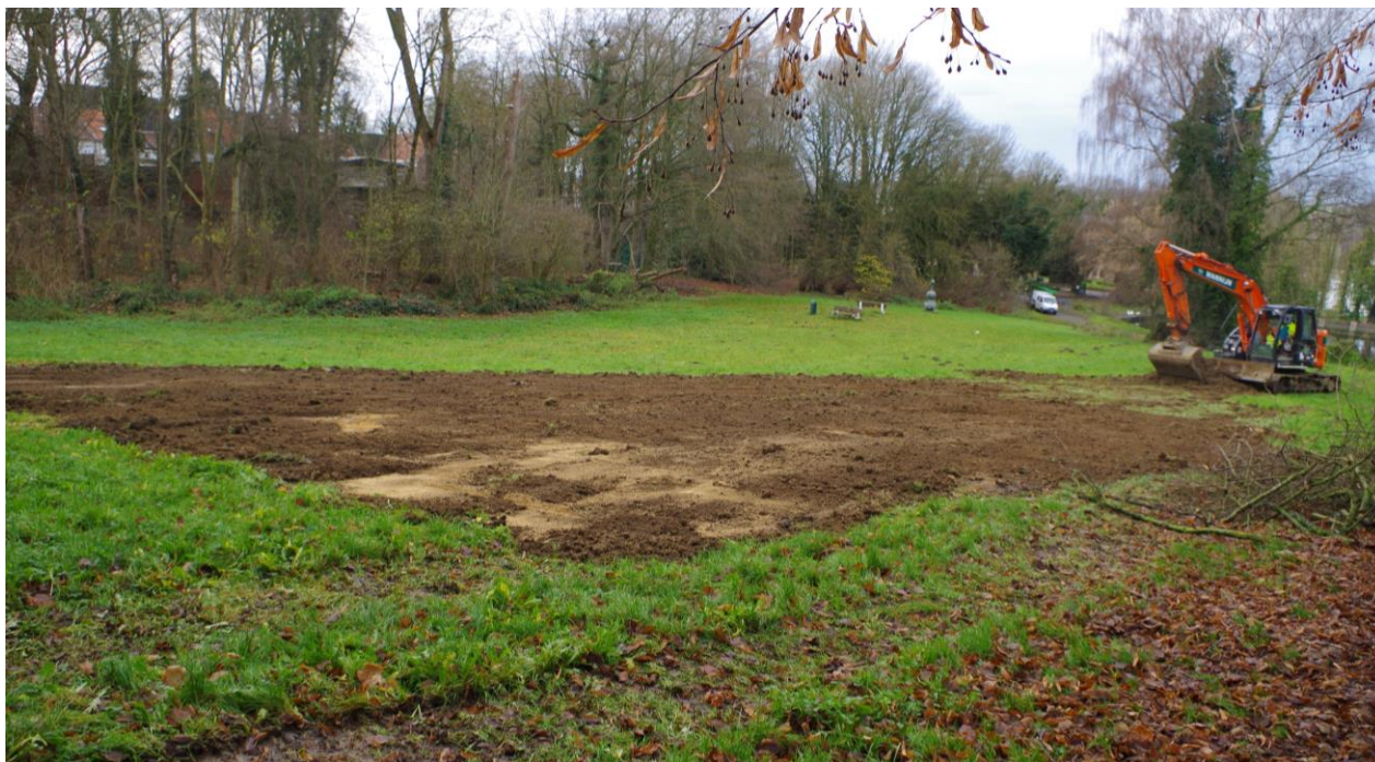
Foto 77 Plaatselijke ophoging bovenop de bestaande toestand, gezien vanaf noordoosten. Rechts op de achtergrond is de parkvijver te zien
