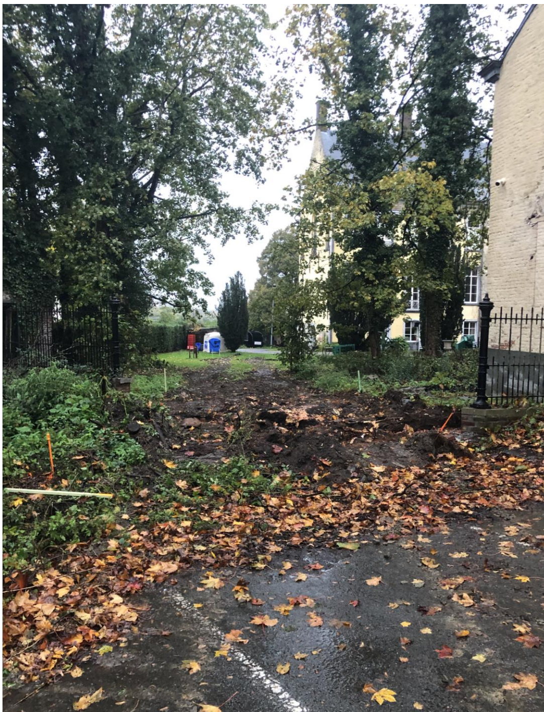
Foto 64 De aanleg van de dienstweg, zicht vanuit het zuidoosten. Rechts is het poortgebouw te zien, rechts op de achtergrond het Abtenhuis
