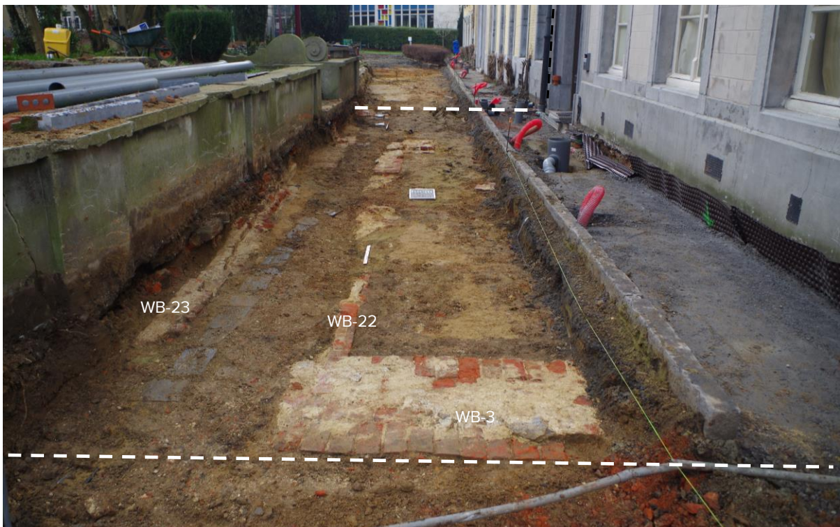
Foto 8 Opbraak van de bestaande toestand ter hoogte van de zuidoostelijke gevel van het Abtenhuis (grondplan A, Fig. 11), gezien vanuit het noordoosten. De witte stippellijnen markeren de zone van de muren. De zwarte stippellijn geeft de scheiding in gevelafwerking weer.
