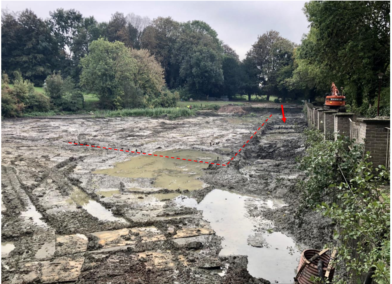
Foto 92 Het ruimen van de vijver, zicht vanuit het noorden. De rode stippellijn duidt de houten, rechthoekige beschoeiing aan, de rode pijl een andere houten fundering/beschoeiing centraal in de vijver
