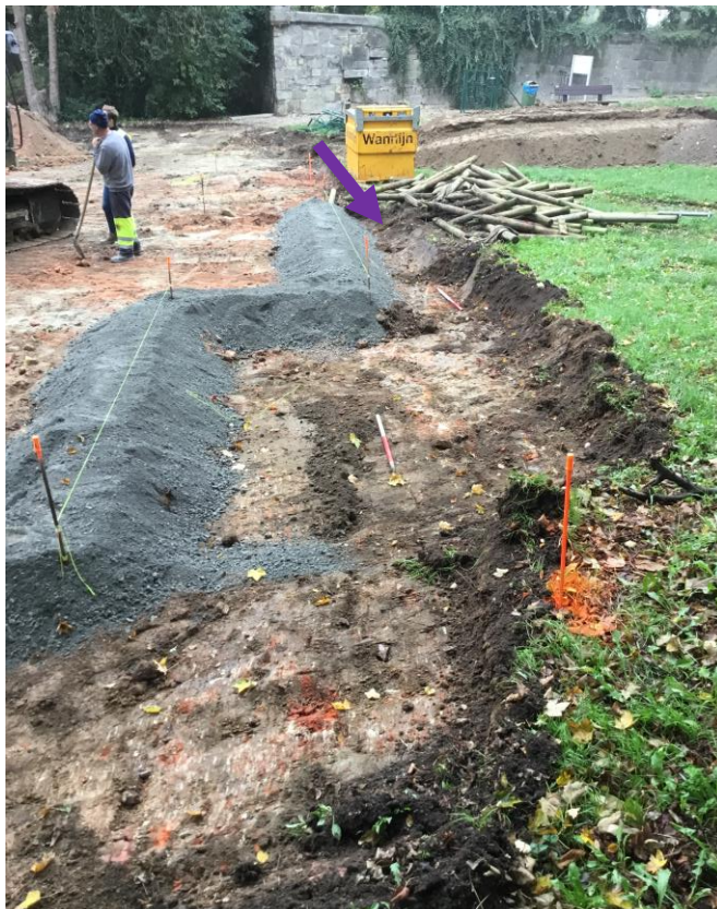
Foto 48 Opbraak en heraanleg van de parking met verdiept gedeelte langs de rand, zicht vanuit het zuidoosten. Ter hoogte van de paarse pijl situeert zich profiel A1C1. Op de achtergrond is de zuidelijke hoek van de kerk te zien
