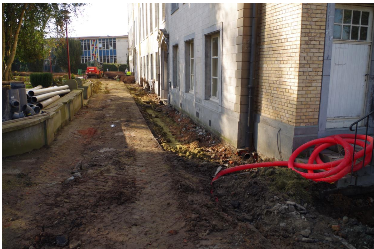
Foto 3 Opbraak van de bestaande toestand ter hoogte van de zuidoostelijke gevel van het Abtenhuis, gezien vanuit het oosten
