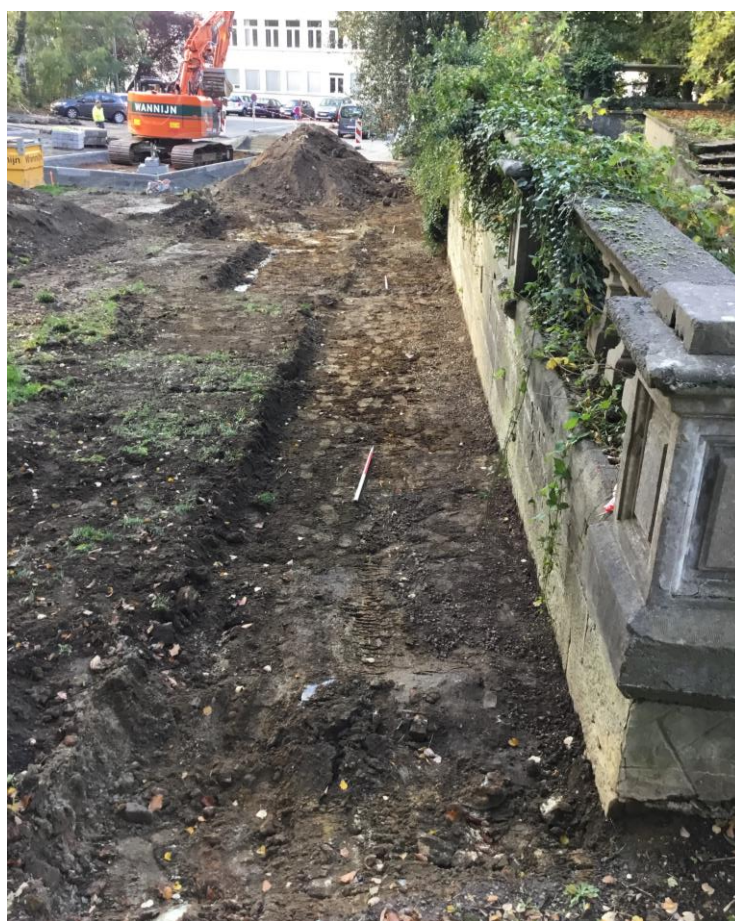
Foto 54 Opbraak van het wandelpad langs de zuidelijke kerkmuren, zicht vanuit het noordoosten
