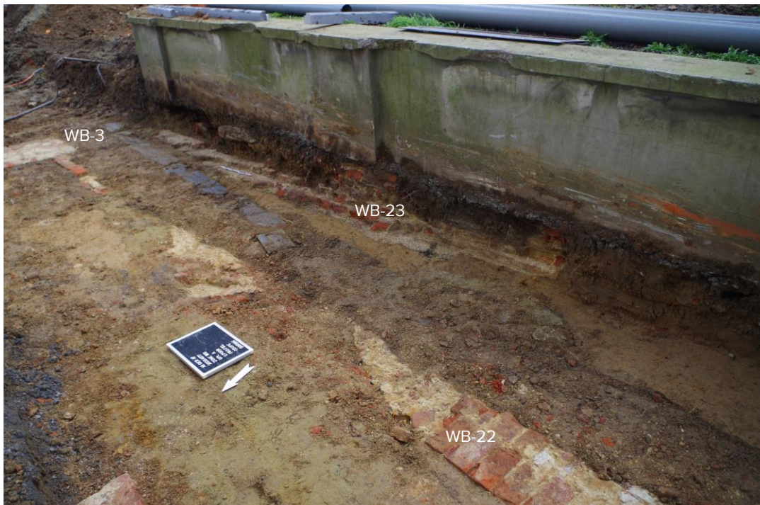
Foto 10 Opbraak van de bestaande toestand ter hoogte van de zuidoostelijke gevel van het Abtenhuis (grondplan A, Fig. 11), gezien vanuit het westen
