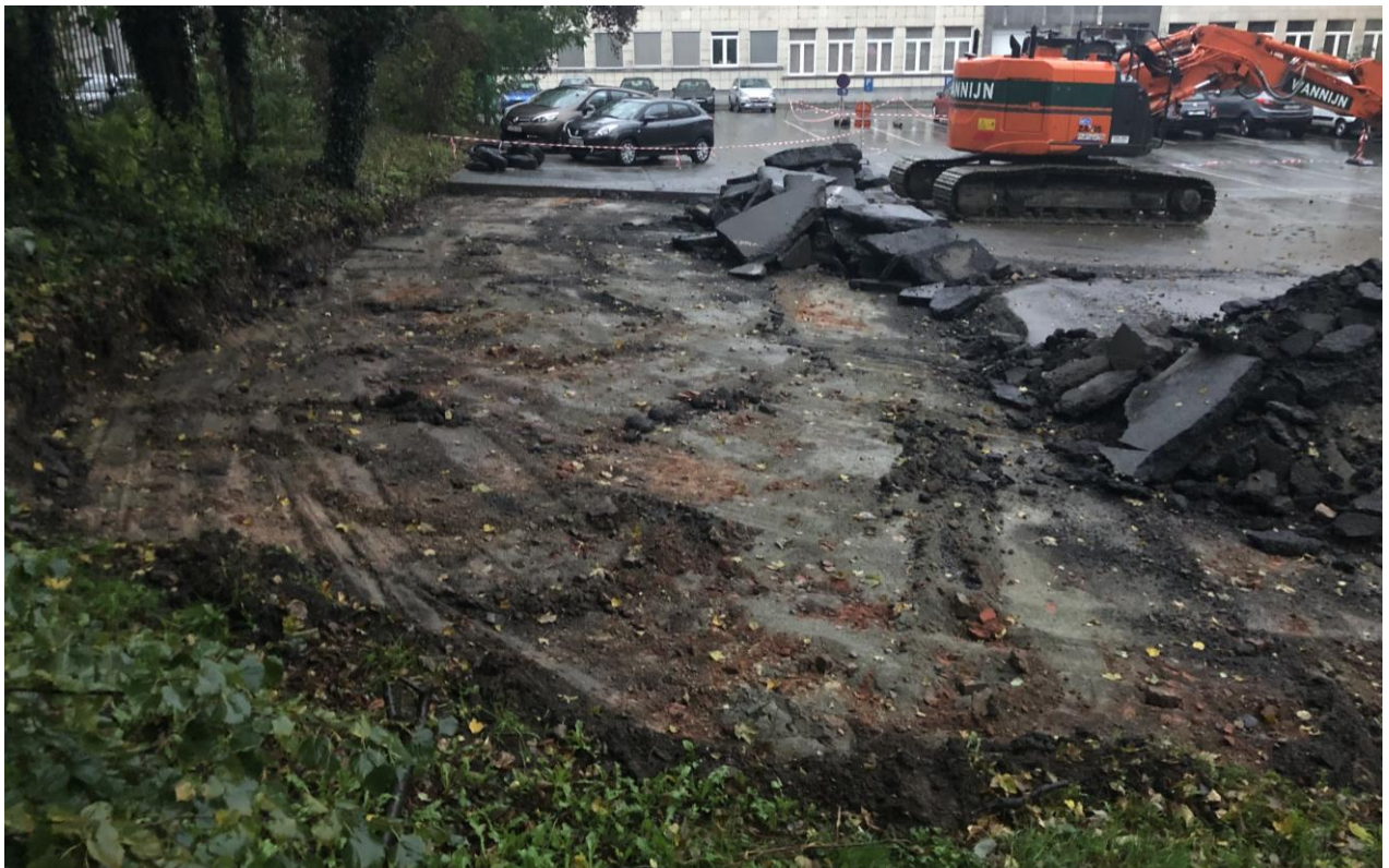
Foto 46 Opbraak en heraanleg van de parking, zicht vanuit het noordoosten
