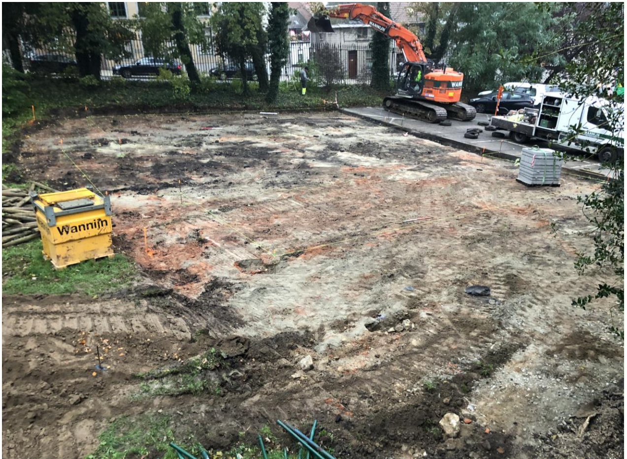
Foto 45 Opbraak en heraanleg van de parking en de hondenloopweide, zicht vanuit het noorden
