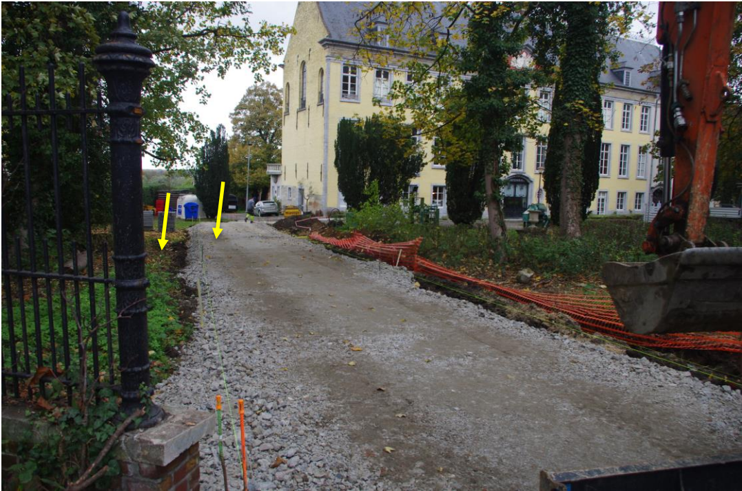
Foto 67 Aanleg van de dienstweg die deels in ophoging gebeurde, de pijlen duiden het hoogteverschil aan, zicht vanuit het zuiden. Op de achtergrond bevindt zich het Abtenhuis
