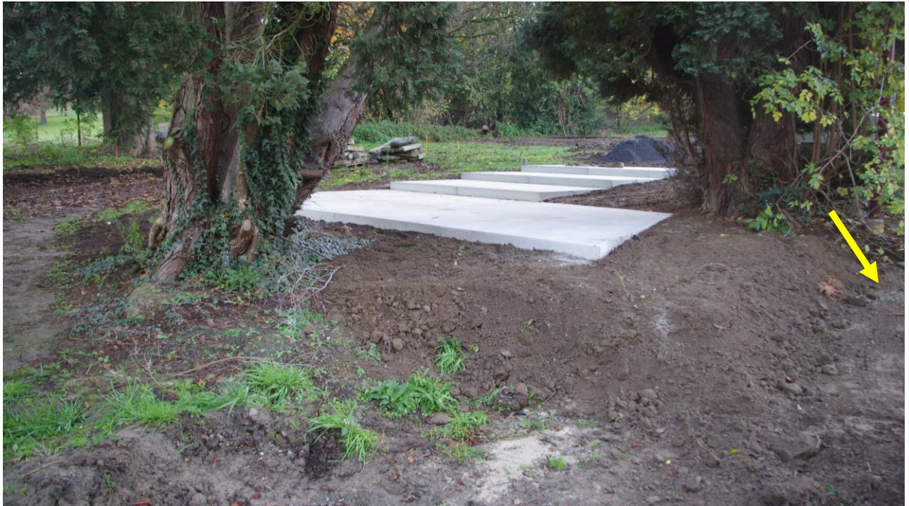
Foto 34 Aanleg van de zit- en speelplateaus ter hoogte van de voormalige conventsgebouwen. De gele pijl geeft de locatie van profiel A14C14 aan, zicht vanuit het noordwesten
