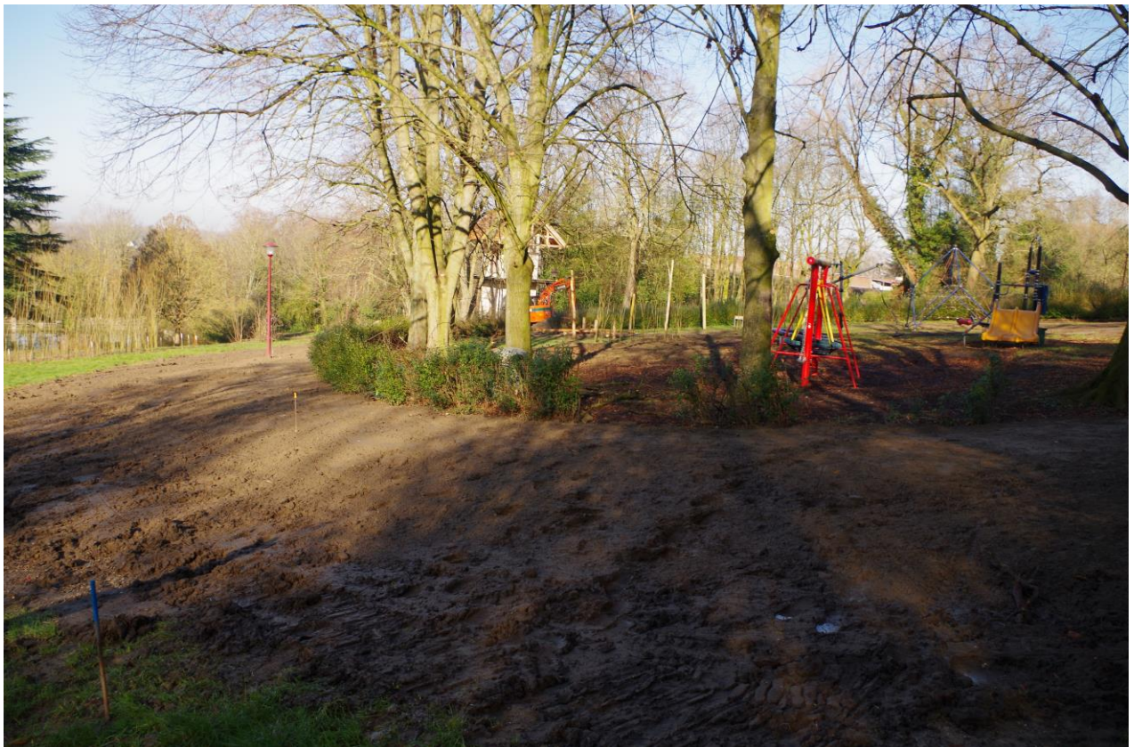
Foto 73 Ophoging met aarde op de locatie van de wandelpaden ter hoogte van de speelzone, gezien vanuit het zuiden
