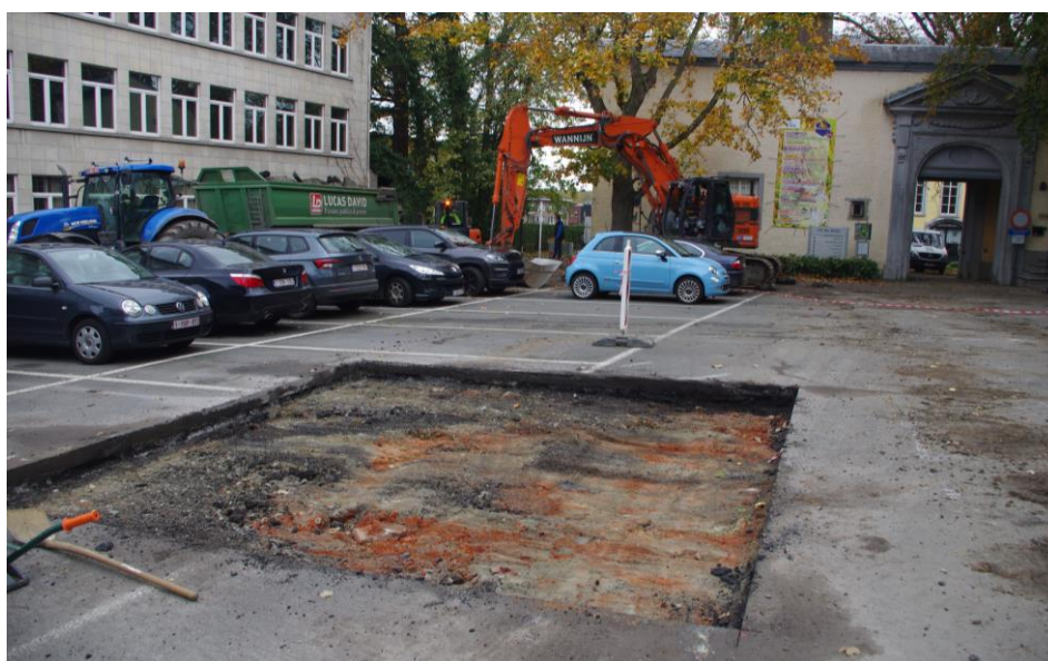
Foto 60 Uitgraving van de boomput op de parking, zicht vanuit het zuidoosten. Rechts is het poortgebouw te zien
