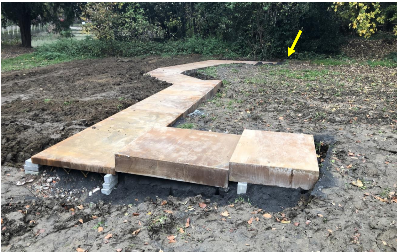
Foto 29 Uitgraving en plaatsing van de cortenstaal ter hoogte van het noordelijk deel van het voormalige koor van de abdijkerk. De gele pijl toont de locatie van profiel A12C12, zicht vanuit het zuidoosten
