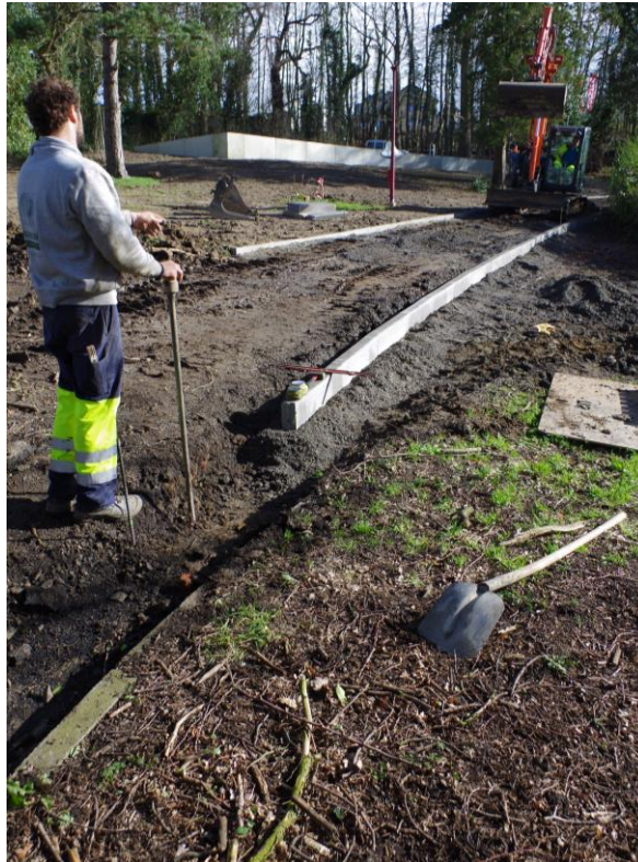
Foto 76 Vervangen van de boordstenen net ten noordoosten van de speelzone, gezien vanuit het noordwesten
