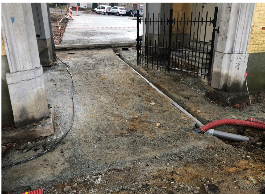
Foto 59 Heraanleg van de toegang in het poortgebouw, zicht vanuit het noordwesten. Op de achtergrond is de parking te zien
