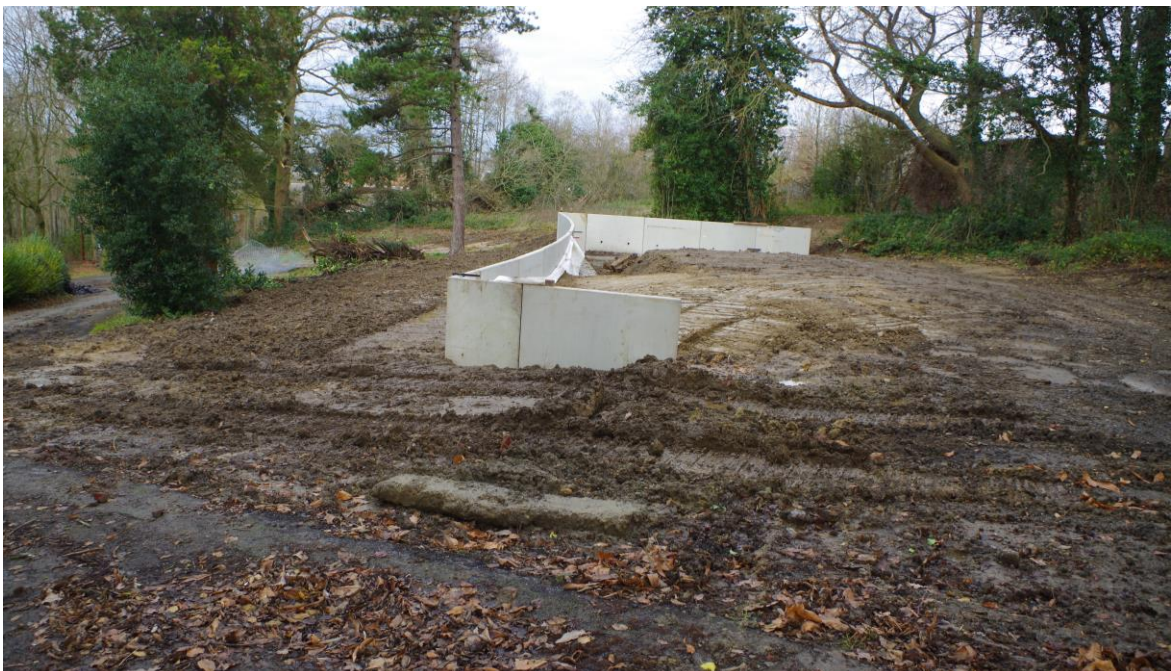
Foto 70 Aanleg van het barbecue-/balkonterras, gezien vanaf het zuiden
