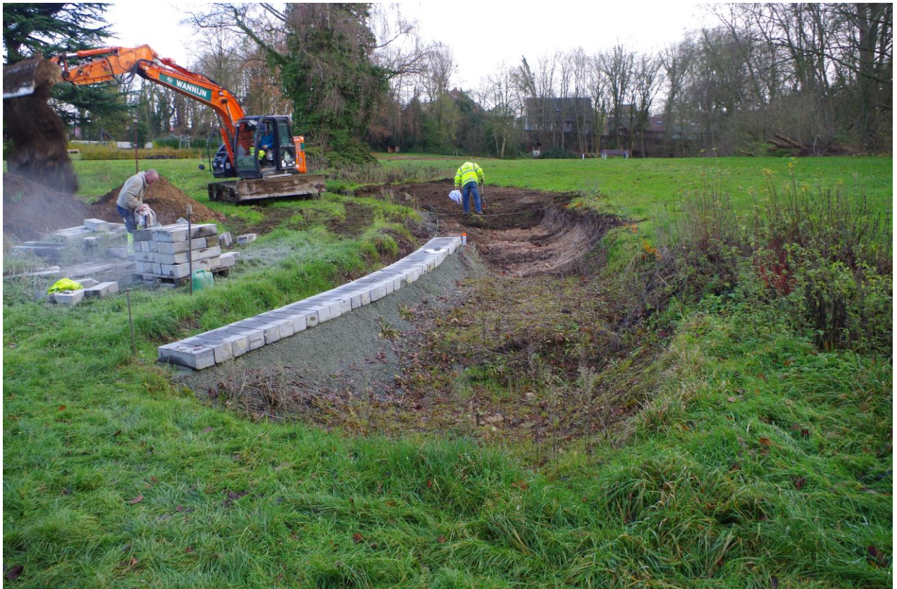
Foto 82 Opvolging van de grondwerken ter hoogte van de speelgoot, gezien vanaf het westen
