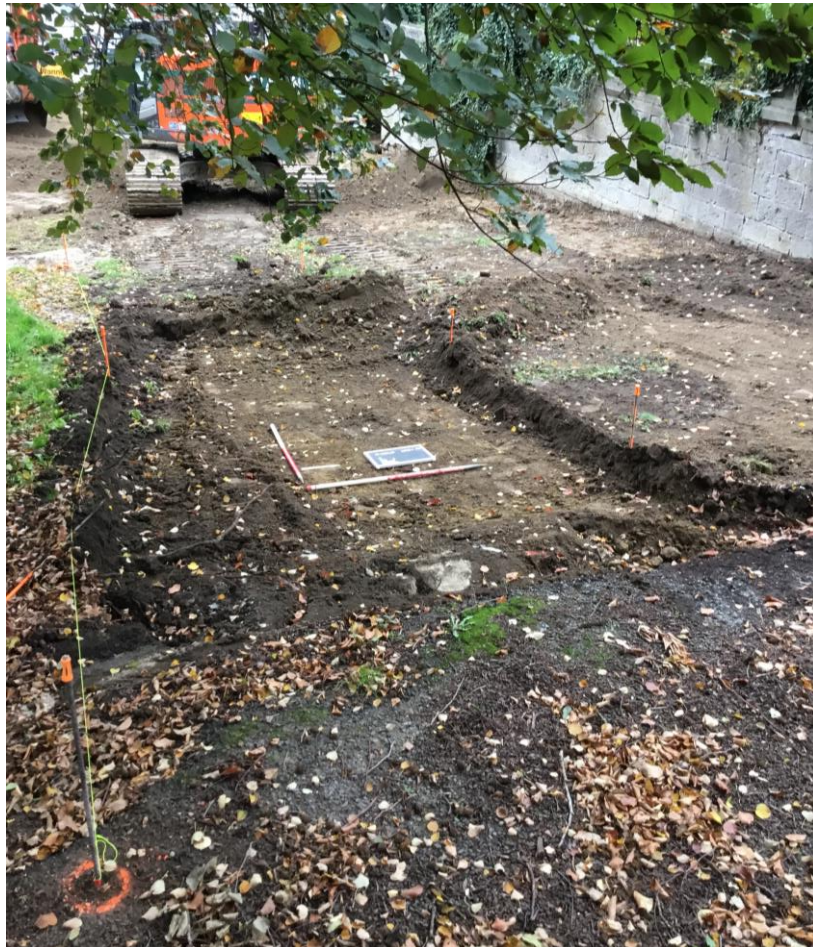
Foto 56 Aanleg van het nieuwe wandelpad ter hoogte van de zuidelijke kerkmuren
