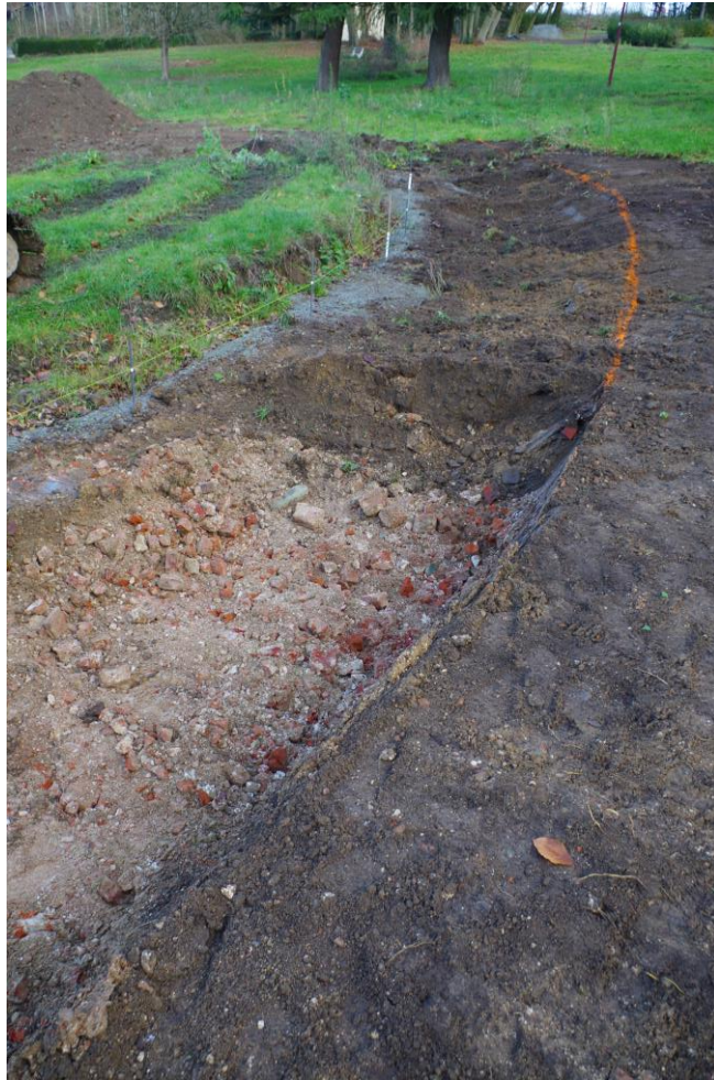
Foto 83 Zicht op de uitgraving van de speelgoot vanuit het westen
