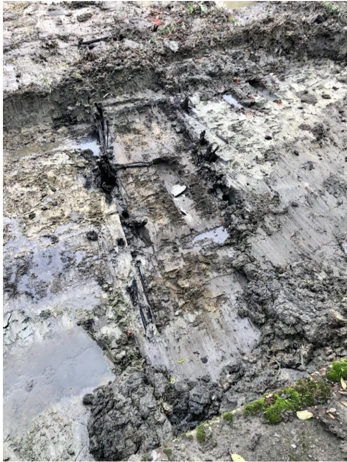
Foto 94 Houten beschoeiing/fundering centraal in de huidige vijver
