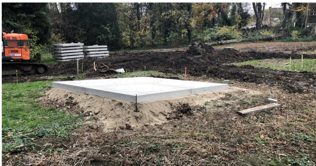
Foto 31 Aanleg van de zit- en speelplateaus ter hoogte van de voormalige conventsgebouwen, zicht vanuit het noordwesten
