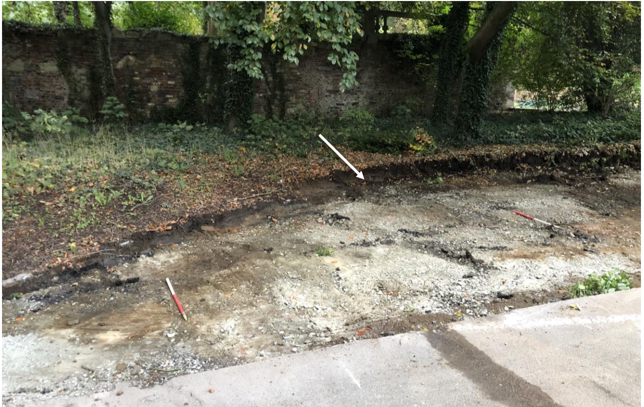
Foto 52 Opbraak van de parking ter hoogte van het poortgebouw, zicht vanuit het westen. Op de achtergrond is de zuidwestelijke kerkgevel aanwezig. De witte pijl geeft profiel A11C11 aan
