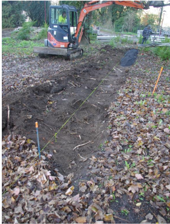
Foto 38 De aanleg van de boordstenen langs de oostelijke zijde van het conventsgebouw
