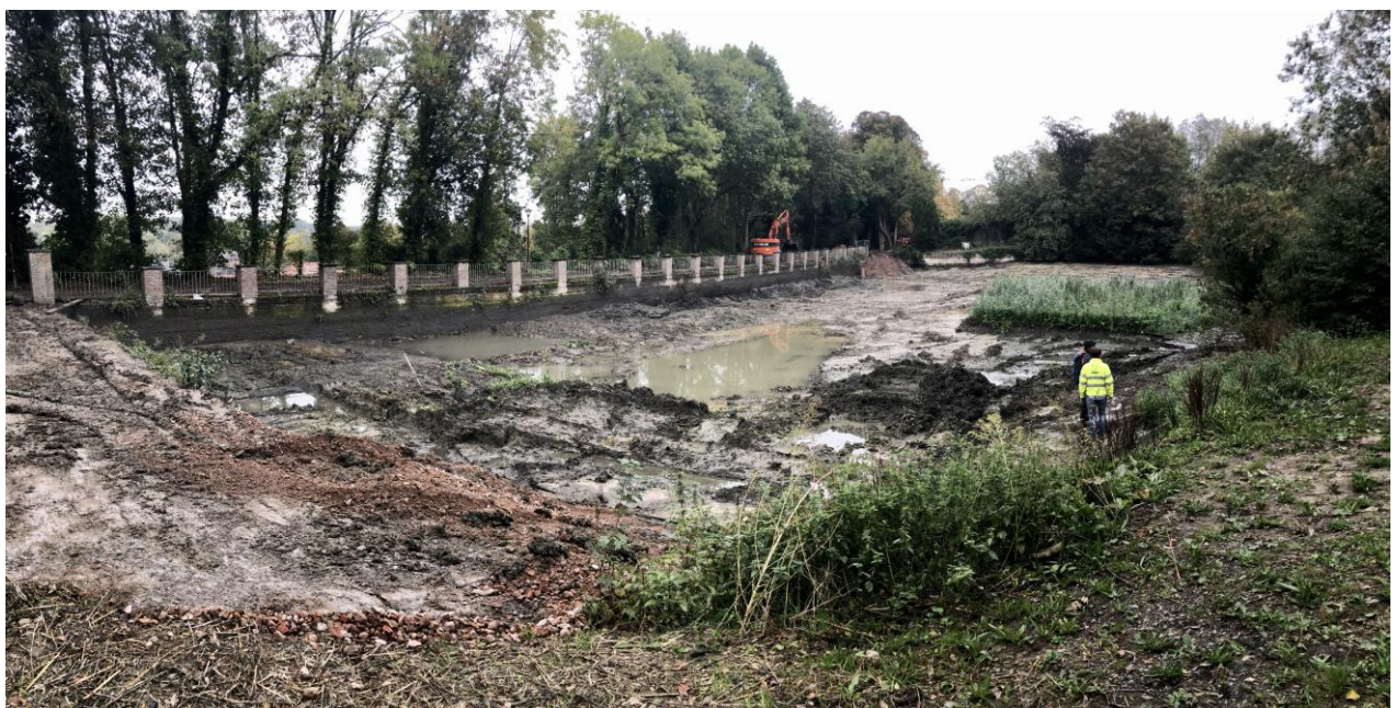
Foto 91 Het ruimen van de vijver, zicht vanuit het zuiden
