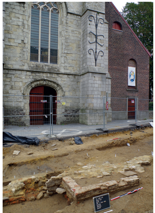
Fundering van een trap die is aangebouwd tegen de kerkhofmuur.
