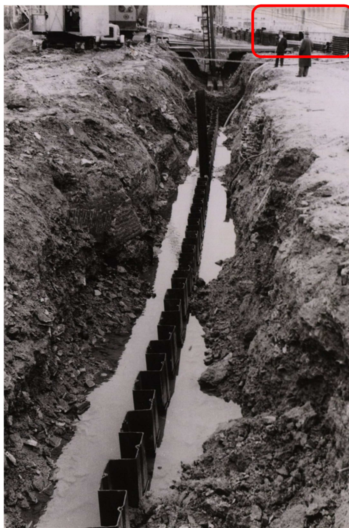
Figuur 29: Zicht op de damplaten voor de rechtekking van de Schelde ter hoogte van Tussenbruggen. Ter situering: in het kader de gebouwen van de huidige rechtbank van eerste aanleg. (Bron: SAO - FO 001165-7)
