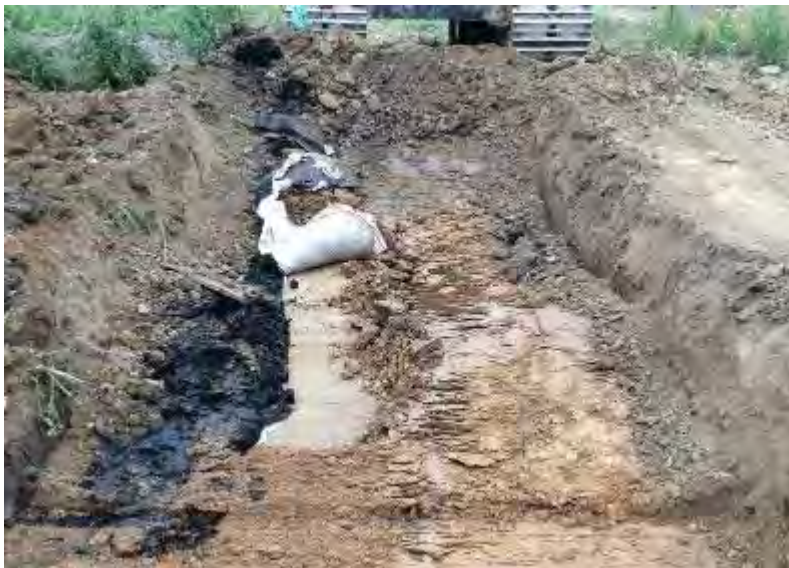
Foto 112. Opgeslagen mest, afgedekt met plastic, wordt geraakt tijdens het graven van de proefsleuven.
