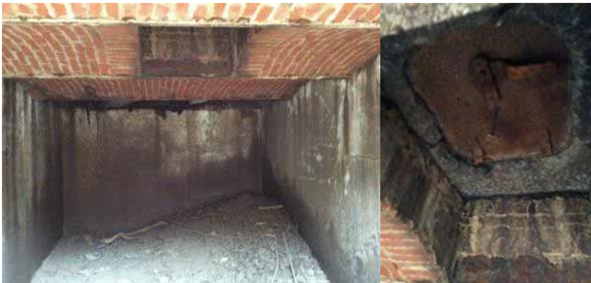
Foto 114. Binnenzicht van de ondergrondse cisterne. Links: zicht binnenin het grootste compartiment. Rechts: zicht op het toegangsluik.
