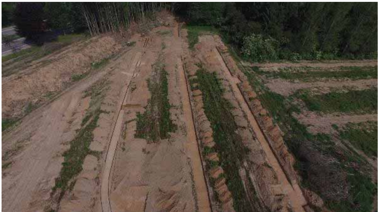
Foto 73. Luchtopname van c. PS40-25 (aangeduid). Zicht naar het noordwesten.
