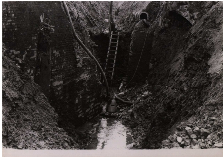
Afbeelding 7: fundering van een toren of van een gedeelte van een poort uit de tweede stadsomwalling (de Meerspoort ?) in Doornikse kalksteen (bron: Archief Oudenaarde).
