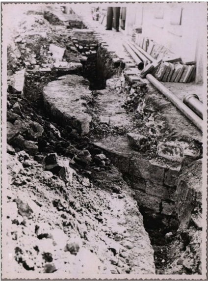
Afbeelding 7: fundering van een toren of van een gedeelte van een poort uit de tweede stadsomwalling (de Meerspoort ?) in Doornikse kalksteen (bron: Archief Oudenaarde).
