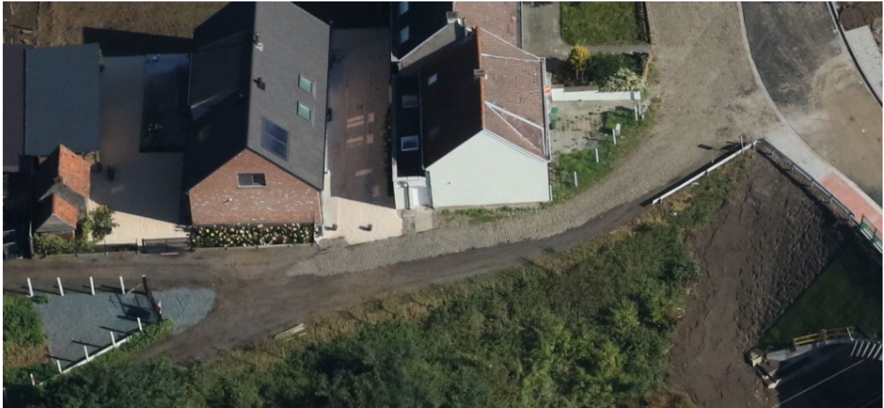
Foto 4: Zicht vanuit het zuidwesten op het zuidwestelijke uiteinde van het projectgebied. Het halfverhard pad, deels met kasseien geplaveid, splitst in het westen en sluit aan op de hoofdbaan van de Kapelhofstraat in het oosten (bron: Plan3D by Vansteelandt).
