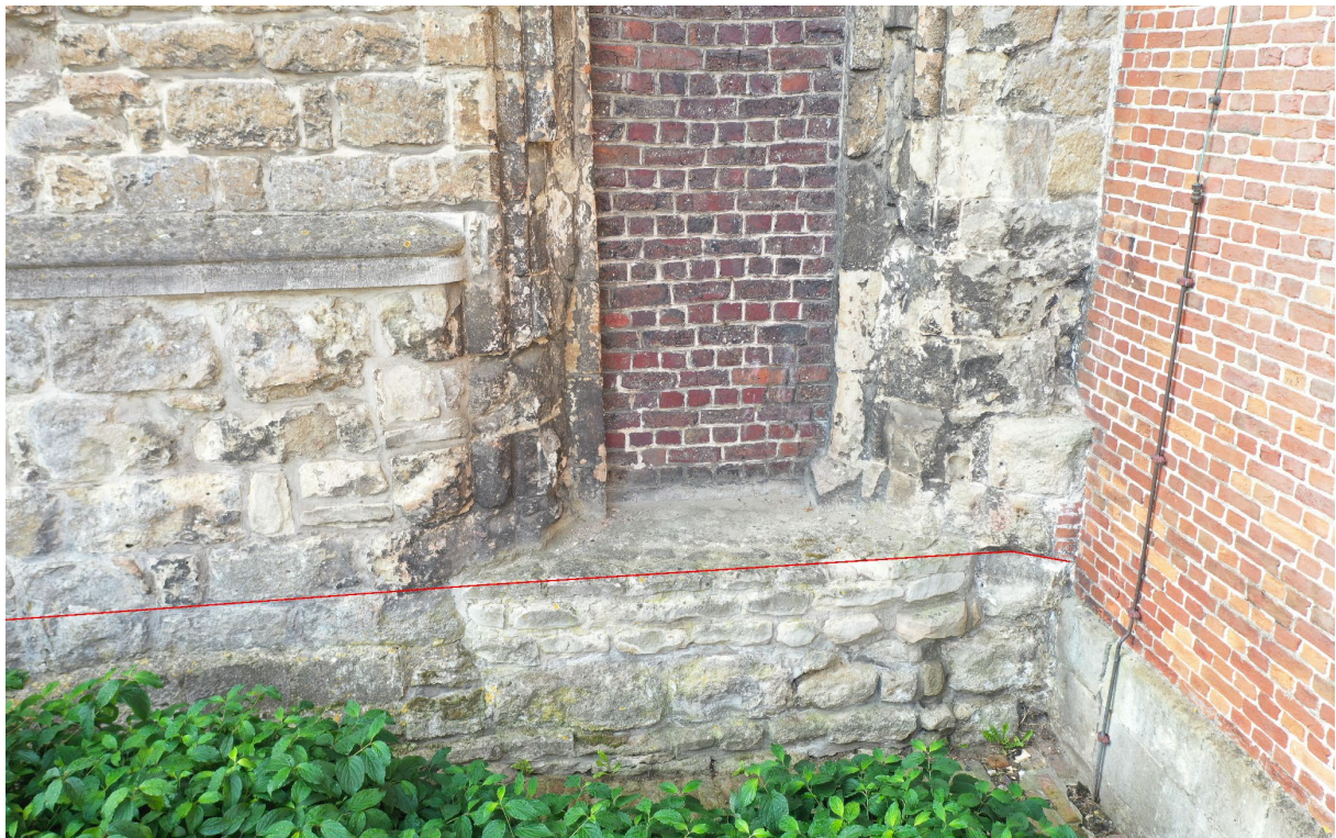
Figuur 53: Zicht op de noordgevel van de kerk op de overgang van het nieuwe schip (baksteen) naar het oude koor (natuursteen). Het oorspronkelijke maaiveld is in rood aangegeven. Onder de rode lijn is de oorspronkelijk ondergrondse fundering met verstek te zien. Ook de verjonging van de gevel boven de rode lijn (aan de afzaat) bevindt zich nu een opvallend stuk hoger dan bij de bakstenen gevel.
