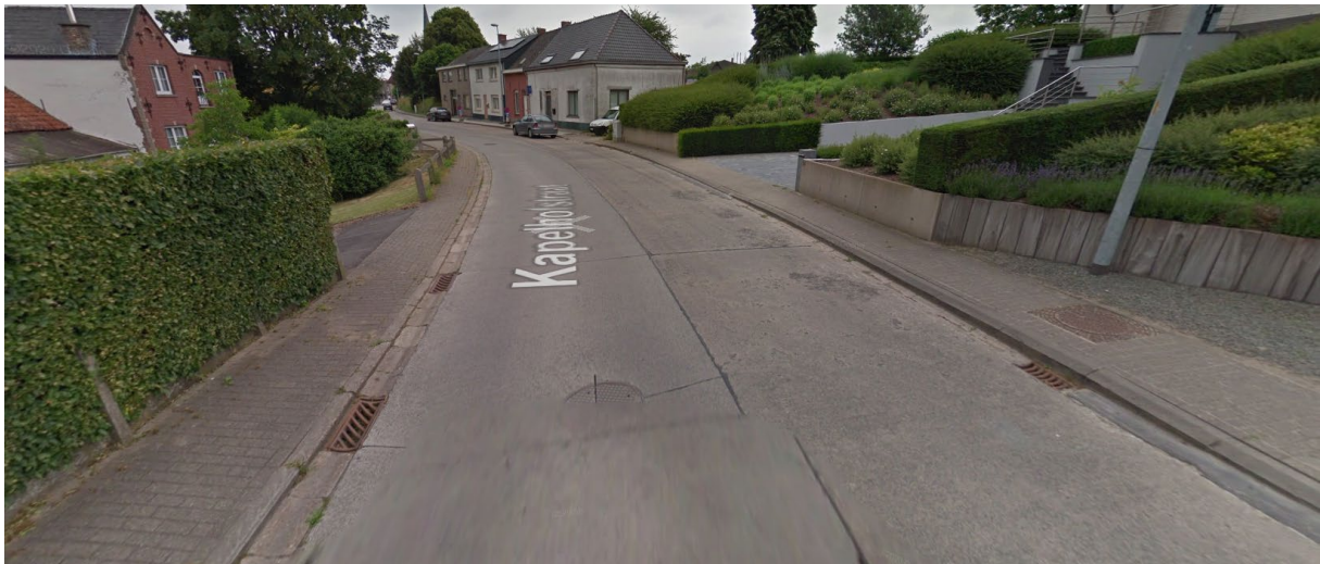
Foto 5: Zicht vanuit het zuiden op de Kapelhofstraat t.h.v. huisnr. 41. De rioolbuizen zitten vanaf huisnr. 1 in het noorden tot hier langs beide kanten van de weg (bron: Google Street View 2018).
