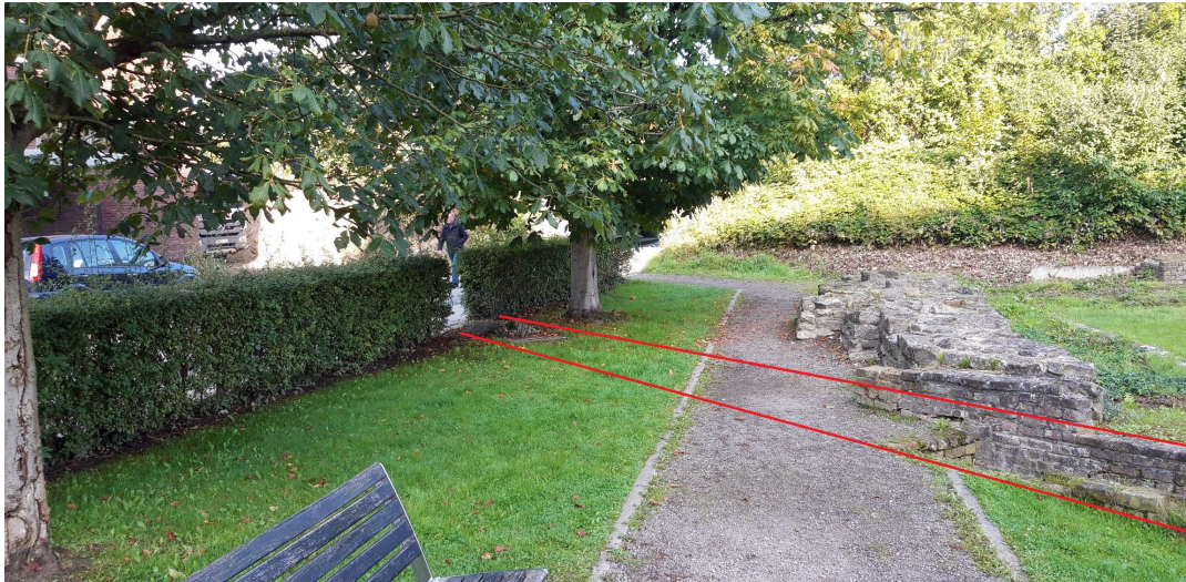
Foto 15: Pad ter hoogte van de opgraving van de kasseiweg. De rode lijnen geven de riool uit de classicistische periode weer die ook zichtbaar is op Foto 14. Het gewelf is alleen nog uiterst links bewaard, rechts is het afgebroken en als rechte muur opgemetst. Dit toont aan dat de kasseiweg minstens 80 cm dieper dan het huidige pad gelegen is.
