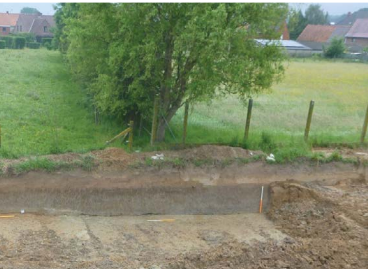
III-B-90, zicht naar het oosten (Hazestraat).
