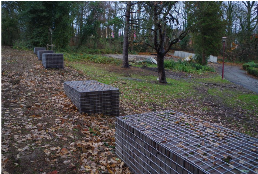
Foto 2: Schanskorven ten noordoosten van het Abdijpark ter evocatie van de oude kloostermuren). (nummer 9 ontwerpplan, Ruben Pedé; zie bijlage voor lokalisatie van de foto's)
