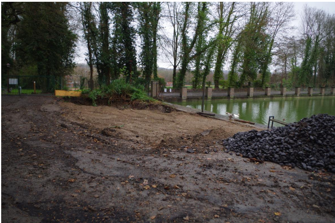
Foto 15: Zicht vanuit het zuidoosten op het opgebroken platform ten zuiden van de vijver (nummer 1 ontwerpplan, Ruben Pede).
