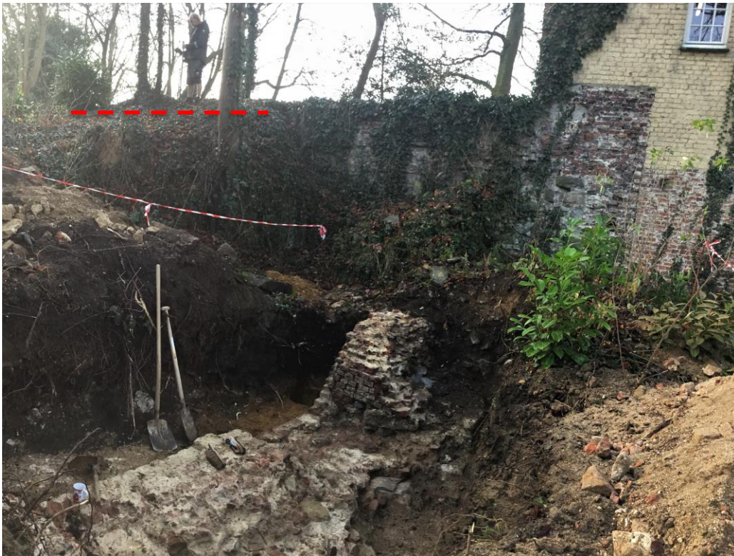
Figuur 32: de rode stippellijn geeft de TAW-waarde aan van 46,4m, de hypothetische 'vloerpas', op de voorgrond is proefsleuf 1 te zien, op de achtergrond de 'keermuur' en het poortgebouw
