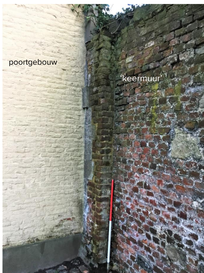
Figuur 20: zicht op de bouwvolumes van het poortgebouw (links) en de 'keermuur' (rechts) langs de huidige parking, het poortgebouw is duidelijk tegen de muur aangebouwd
