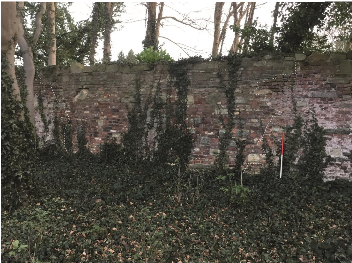
Figuur 34: zicht op de 'keermuur' vanop de huidige parking, tussen de witte stippellijnen is een jonger bouwvolume aanwezig, vermoedelijk geeft dit de oorspronkelijke locatie aan van de (uitgebroken) toegangstrap ter hoogte van de westgevel van de kerk
