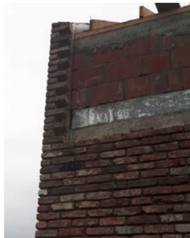
bij het stilleggen van bouwwerken is het cruciaal om snel op te treden, ook in het belang van de bouwheer
